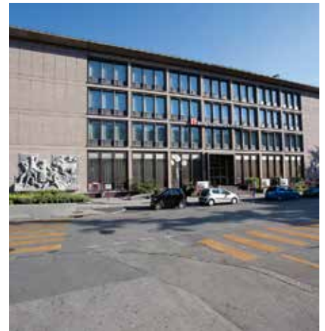
Walliser Kantonalbank modernisiert Arbeitsumgebung mit Soft- und Hardware von Igel. (Bild: Robert Hofer)
